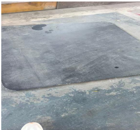
卸油区上口违规使用钢板已整改 整改前
